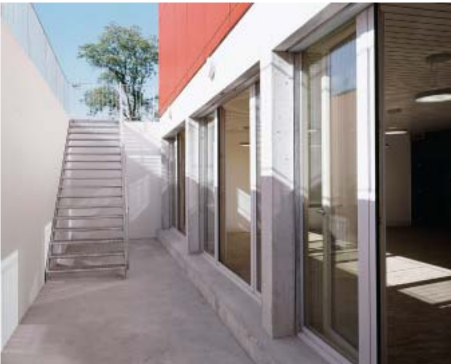
Auch die kleinen Wohnungen wirken als liches, geräumiges Raumkontinuum. Im Untergeschoss wurde ein Bürgersaal eingerichtet, der für Sitzungen und Veranstaltungen genutzt wird.
